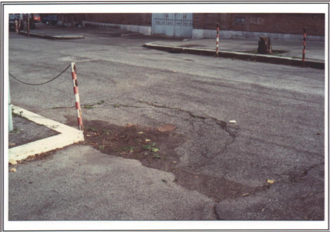
Foto n. 4 – Deformazione ed abbassamento della pavimentazione stradale su via San Giosafat
