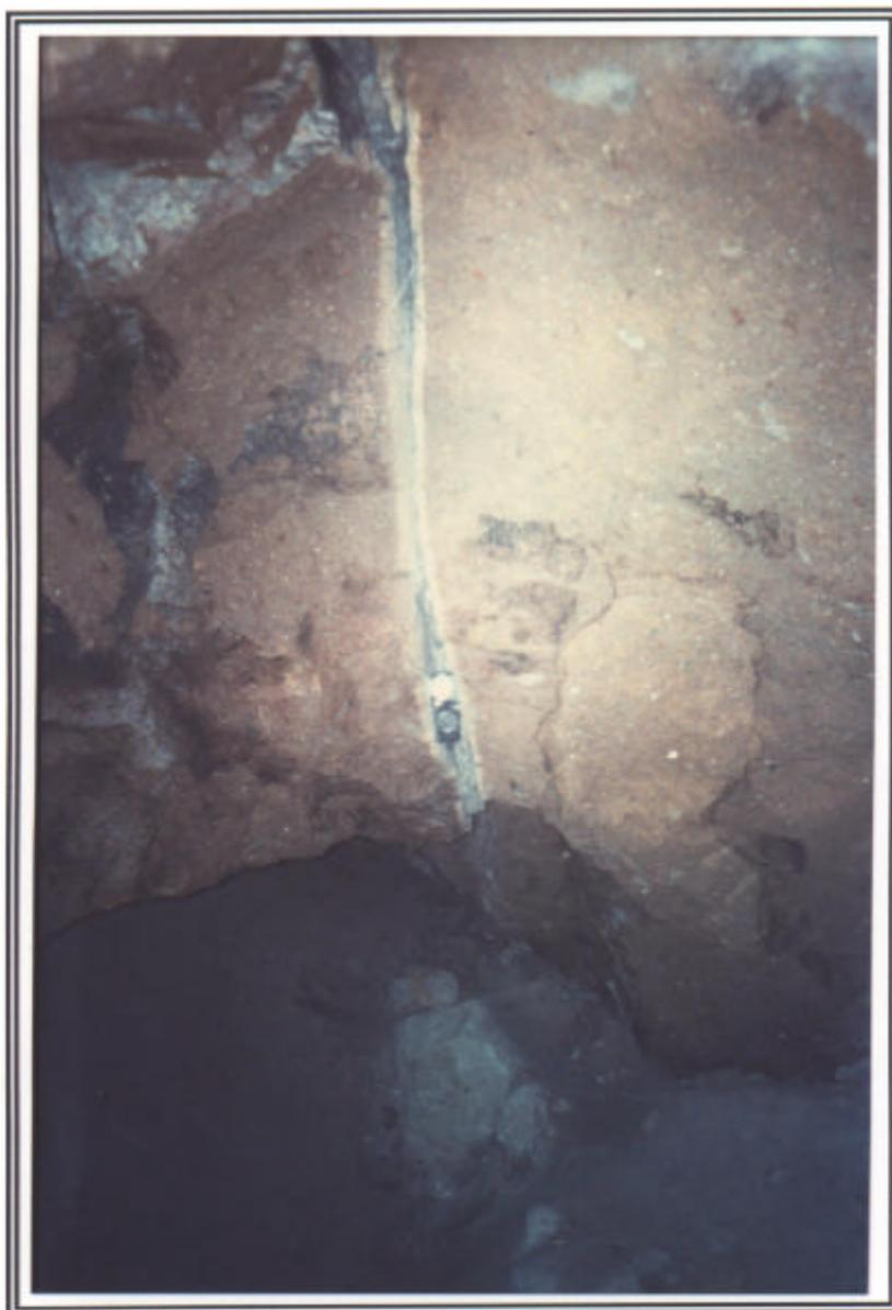
Foto n. 5 – Discontinuità estese interessano frequentemente le zone di calotta; nella foto, particolare della volta della galleria che sottopassa l'edificio religioso dei Padri Basiliani
